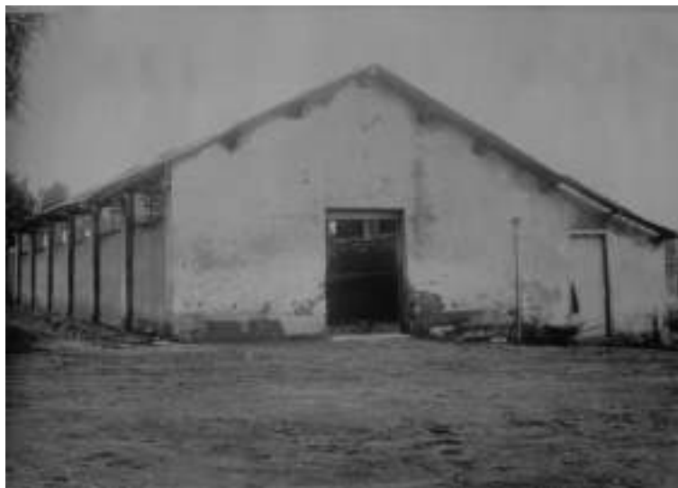
Fotografia 1 – Cocheira que abrigou a Escola Isolada Mista do Instituto Serumtherápico
