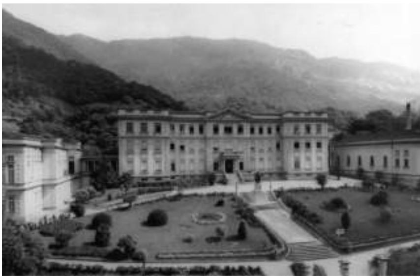
Figura 5 – Fachada do Colégio Marista São José, Tijuca
