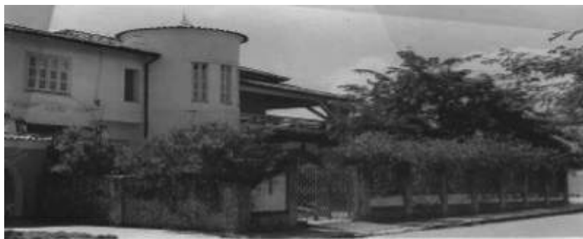
Figura 2 – Segundo do prédio da Escola de Música de Teresina
